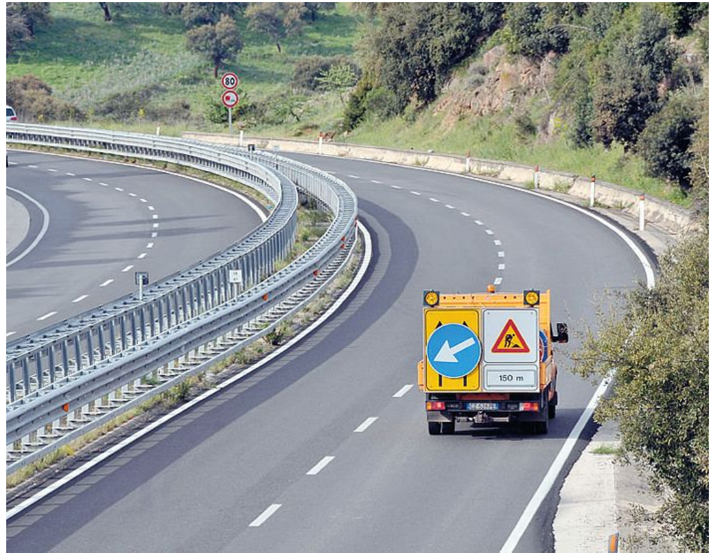
Un mezzo dell'Anas che avvisa gli automobilisti dei lavori in corso lungo la 131 dcn
